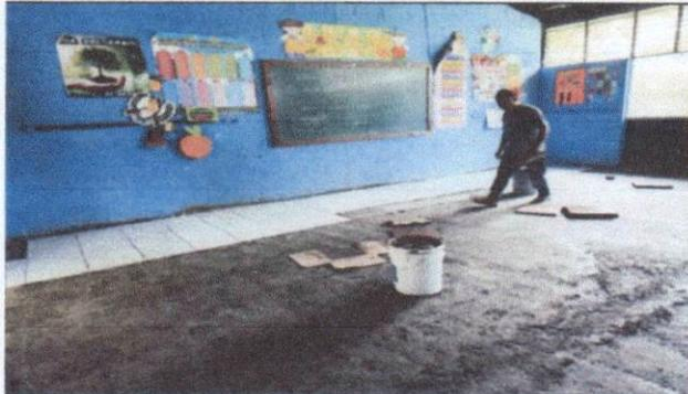
Foto1: SUSTITUCIÓN DE PISO DE GRANITO POR PISO CERÁMICO MÓDULO 1.
